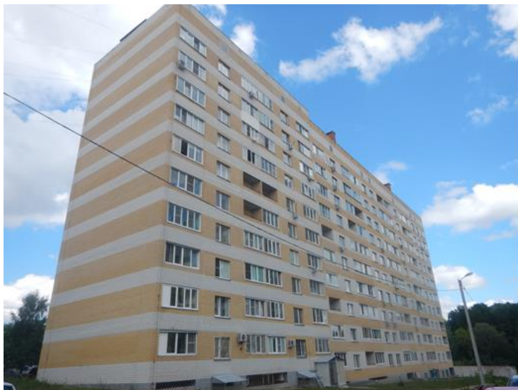
Рисунок 1. Фасад жилого дома по адресу: г. Нижний Новгород, ул. Вятская, д. 9
