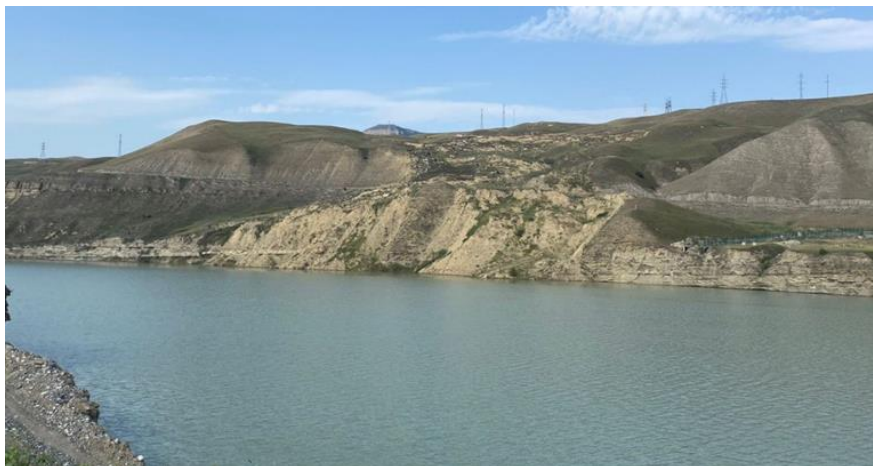
Рисунок 1. Оползень 02.09.2022 г., уровень водохранилища 731,00 м.
